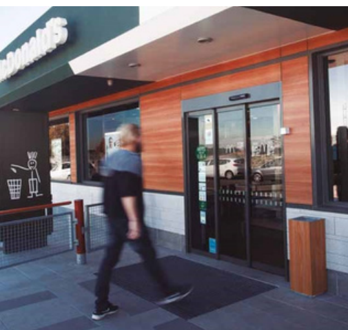
Porta automática de abertura telescópica. Sector restauração.
